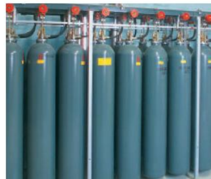
Figures 4 et 5: Bouteilles à gaz utilisées dans les installations fixes de lutte contre l'incendie
