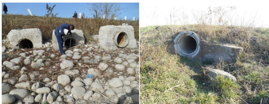
Рис.6. Аварийные водосбросы трубчатые, вид с верхнего бьефа.
