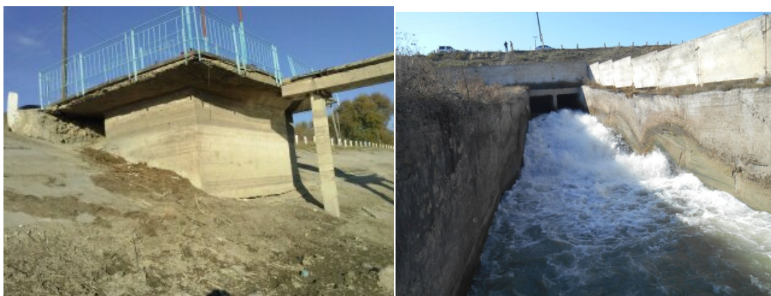
Рис.2. Вид на шахтные водосбросные сооружения в верхнем и нижнем бьефе плотины.
