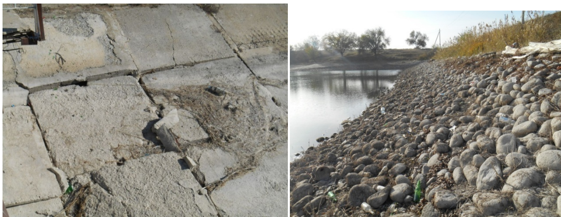
Рис.1. Плотины с железобетонным и каменным креплением откосов.
