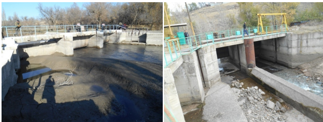
Рис. 4. Большие гидроузлы. Особенностью их является пропуск большого объема воды, сложность управления, значительные эксплуатационные расходы.
