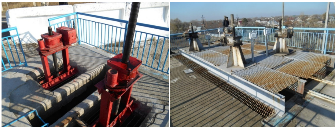
Рис.8. Механизмы подъема плоских затворов
