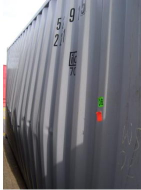
Рис. 7.70 Выпучивание стенки
