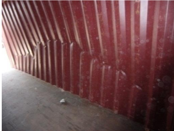
Рис.7.5066 Повреждение боковой стенки ГТЕ
