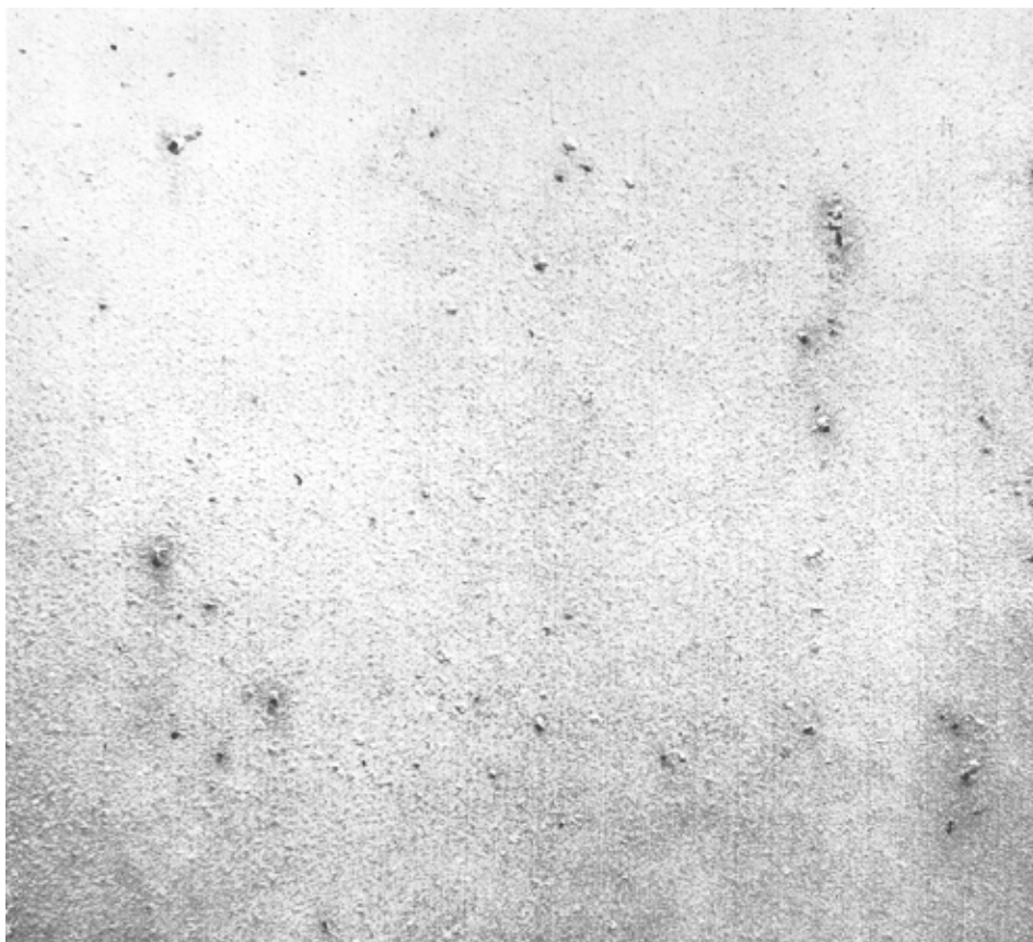
Figure 2 de la norme ISO 4628-3 (Peintures et vernis — Evaluation de la dégradation des surfaces peintes — Désignation de l'intensité, de la quantité et de la dimension des types courants de defaults— Partie 3: désignation du degré d'enrouillement) Degré d'enrouillement Re1
