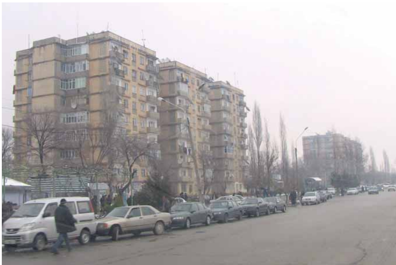
Фотография 8. Многоэтажные дома, требующие реконструкции
