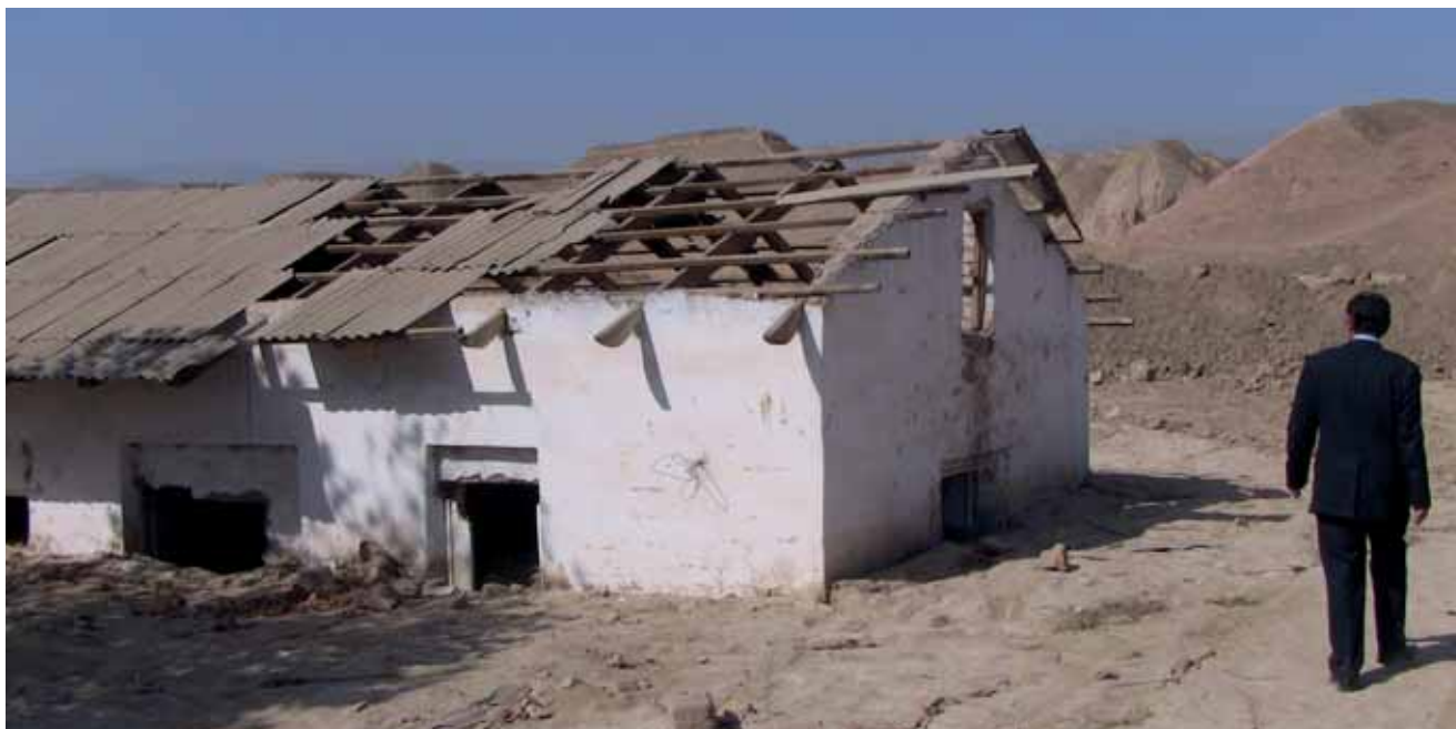
Фотография 1. Семейный дом, разрушенный оползнем, район Ванджа
