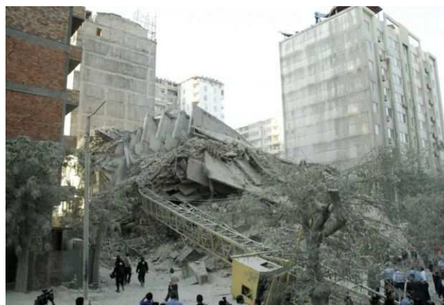
Рисунок 14. Разрушенное здание в Баку, август 2007 г. Источник: Day.az
