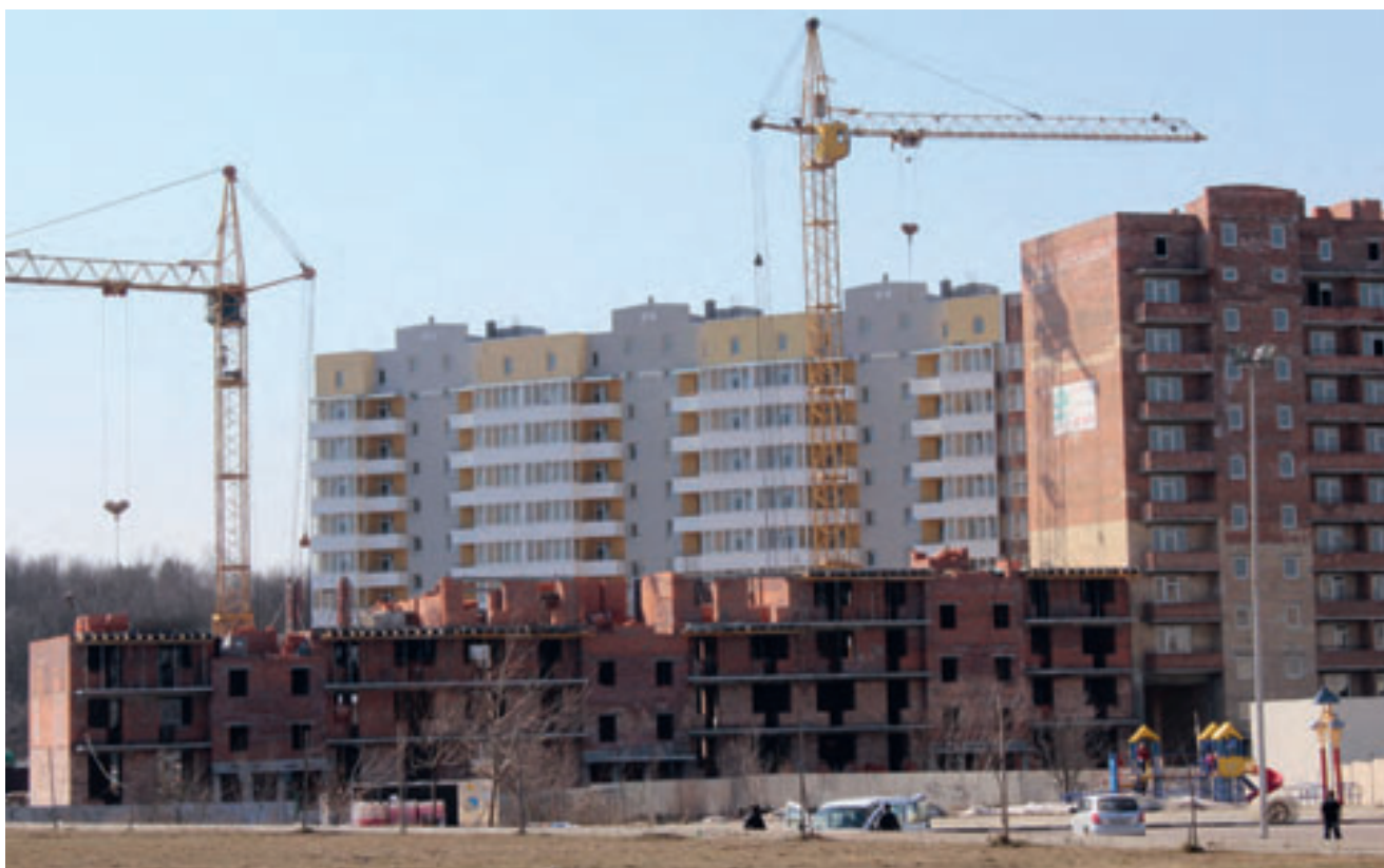
Иллюстрация 8. Строительство многоквартирного дома
