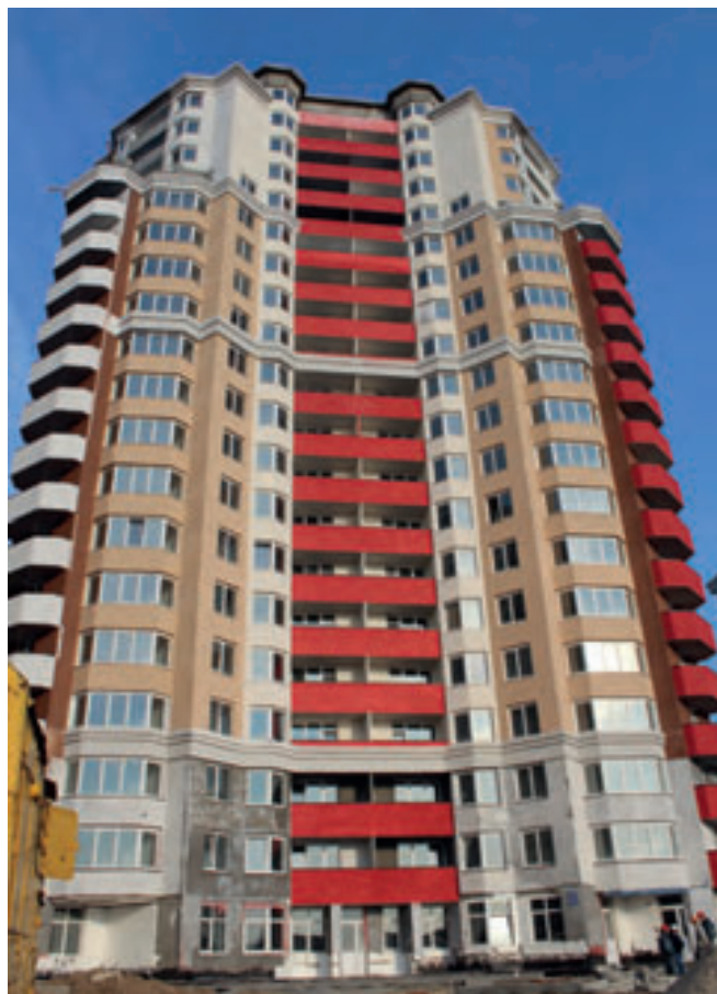
Иллюстрация 5. Строительство жилого дома социального назначения
