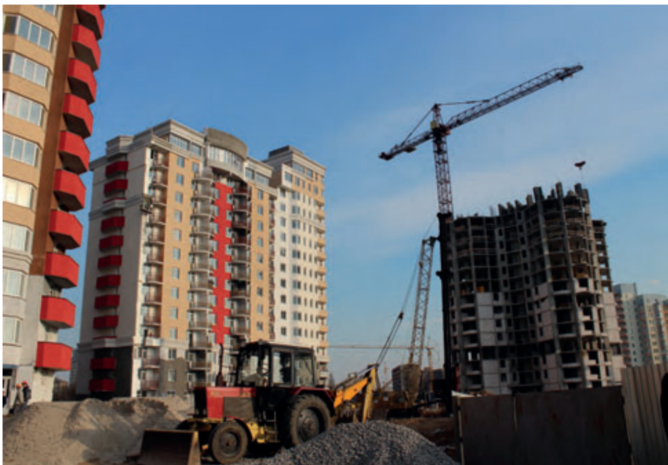
Иллюстрация 9. Строительство жилого дома социального назначения
