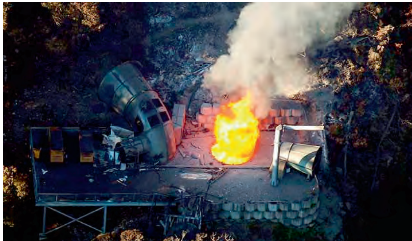
Figura 9.12 Incendio en el pozo de retorno del aire tras la tercera explosión
