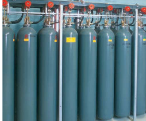
Рис. 4 и 5: Газовые баллоны, используемые в стационарных системах пожаротушения
