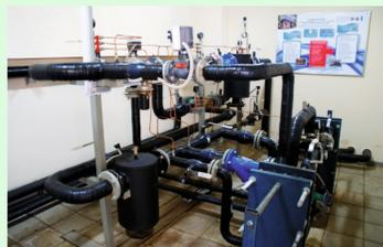
При комплексе работ по термомодернизации зданий устанавливаются **автоматизированные системы регулирования теплопотребления и общедомовые приборы учета тепловой энергии**, как обязательный элемент реконструкции
