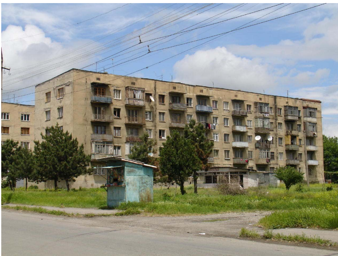
Многоквартирный жилой дом в Гори
