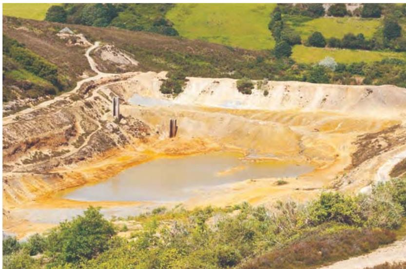
**Дамба хвостохранилища** – насыпь, возводимая для удержания хвостов, или дамба, огрождающая площадку для складирования удаляемых хвостов. Термин «дамба хвостохранилища» обозначает насыпи, стены дамбы или другие сооружения, образующие контур чаши хвостохранилища, предназначенные для укладки отвальных хвостов и удержания хвостов, а также технологической воды, которые возводятся контролируемым образом.
