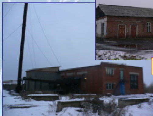
Котельная «Центральная» (с. Тогур)
