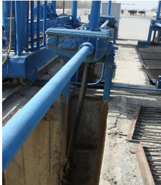
Рисунок – 2 Деформация грузовых винтов подъемников затворов наносопромывных галерей.
