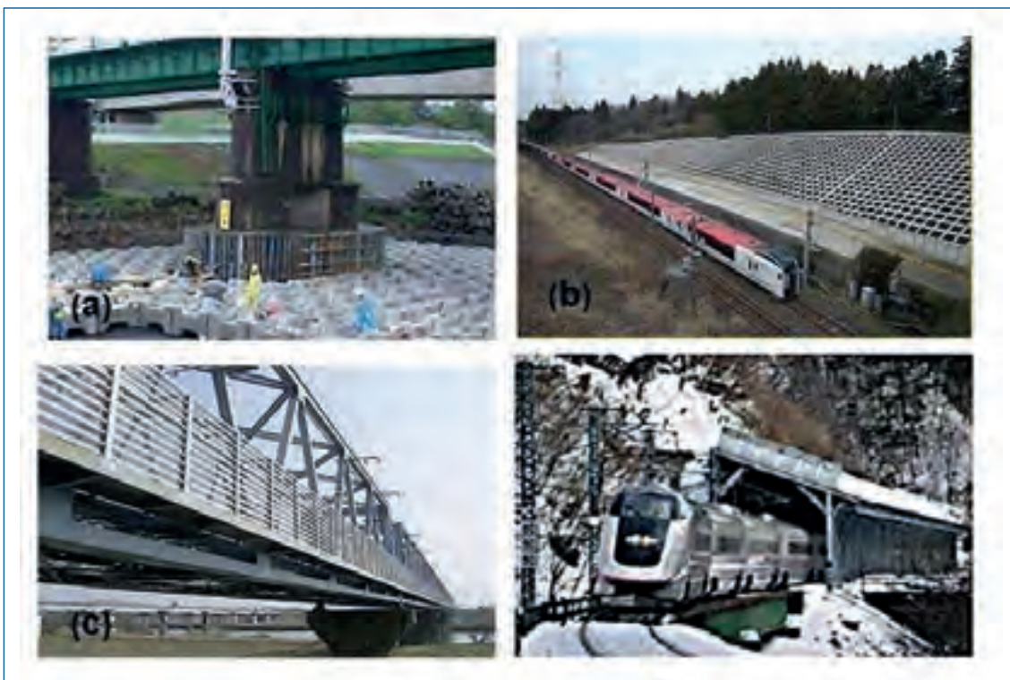
Figure 56. (a) Protection contre l'affouillement; (b) Renforcement du talus; (c) Écran coupe-vent; (d) Auvent de protection contre les avalanches.
