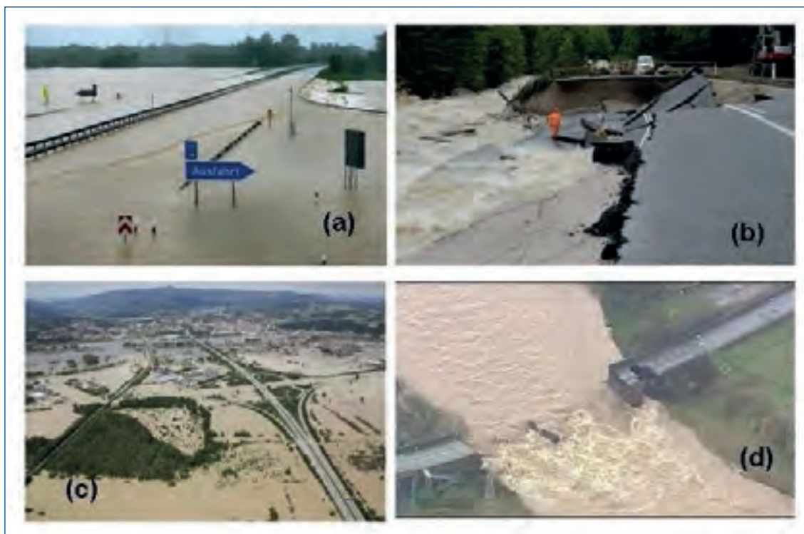
Figure 26. Dommages provoqués par l'inondation de routes. (a) Autoroute 8 (Munich-Salzburg) à Grabenstaett près de Traunstein, sud de l'Allemagne (début juin 2013, Matthias Schrader, AP); (b) Affaissement de la chaussée entre Lofer et Waidring, dans le Tyrol (Autriche) (3 juin 2013, Kerstin Joensson, AP); (c) nœud autoroutier inondé à Deggenförf; (d) effondrement d'un pont dans le comté de Cumbrie (Royaume-Uni) en novembre 2009 ( http://news.bbc.co.uk/2/hi/uk_news/8369934.stm ).
