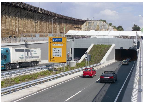
Source: Herrentunnel Lübeck GmbH & Co. KG
