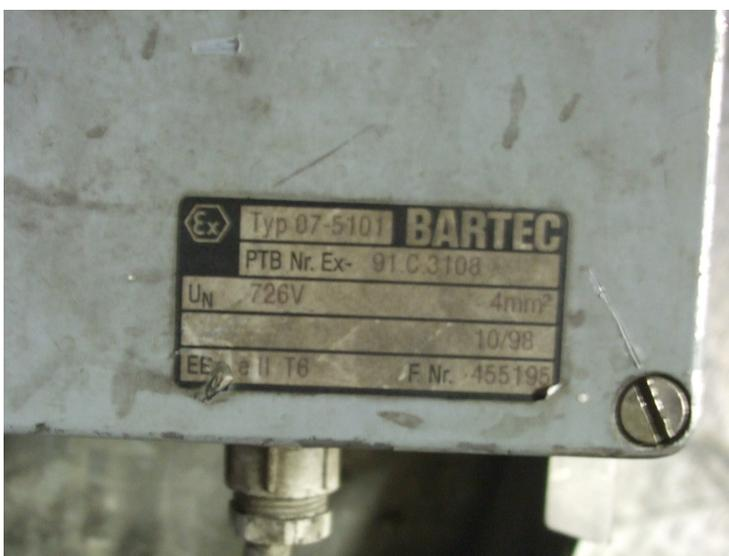
*EX-Kennzeichnung des Ventilators gemäß ATEX-Richtlinie.*
