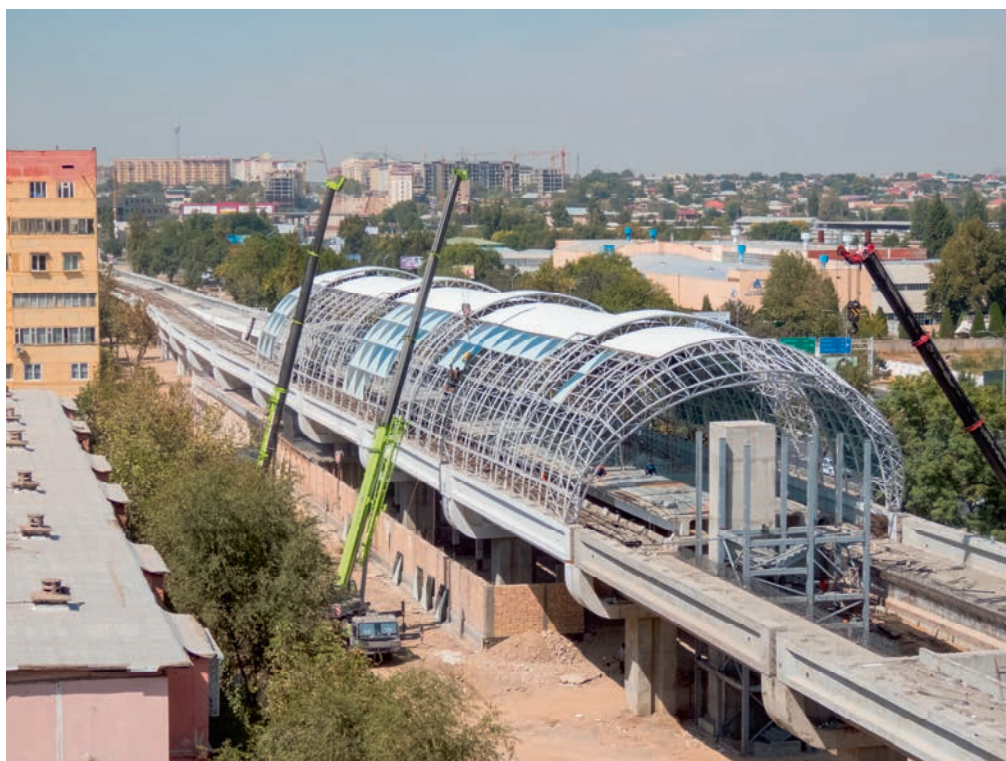
Фотография 14.4: Строительство новой станции наземной ветки Ташкентского метрополитена по Ахангаранскому шоссе
